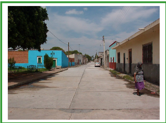
Pavimentación de la Calles Morelos, de la comunidad de Jéruco, municipio de Cuitzeo.
